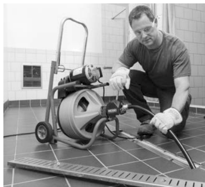
Figura 16 – Uso de la máquina con manguera-guía
