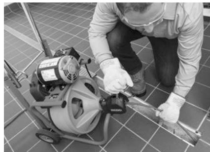
Figure 15 – Utilisation du K-400 avec AUTOFEED
