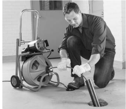
Figura 10 – Ejemplo de cómo extender el desagüe para que el acceso quede a menos de 2 pies (60 cm) de la salida del cable
