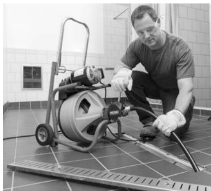
Figure 16 – Utilisation du guide-câble
